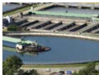
Traitement tertiaire municipal ou industriel
